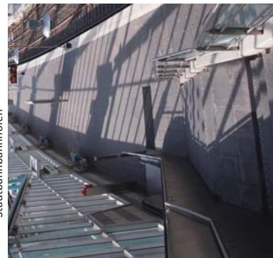
Abb. 56: Fehlende taktile Führung zum Ausgang an Stadtbahnbahnhöfen
