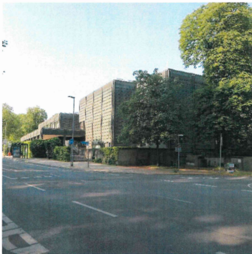
Abbildung 11: Nord- und Ostseite mit Stützmauern und Treppe (LWL-DLBW/Dietrich)
