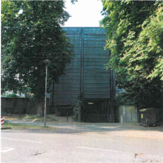
Abbildung 12: Nordseite mit Betonskulptur und Rampe zur Anlieferung (LWL-DLBW/Dietrich)
